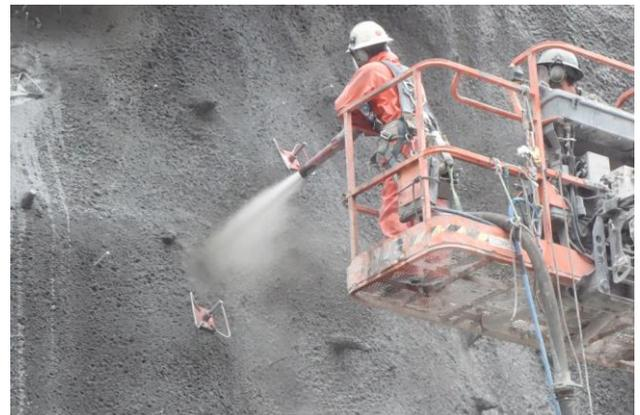
Abb. 7 Spritzbetoneinbau
