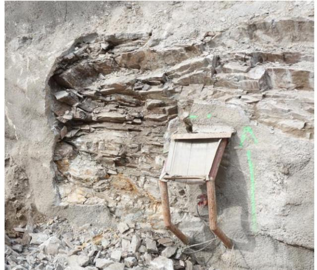
Abb. 8 Zerklüftetes Gestein unter altem Spritzbeton. Links: Schutzabdeckung eines Messinstrumentes
