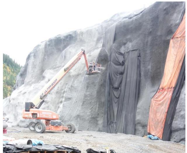
Abb. 6 Spritzbetoneinbau von der Hebebühne
