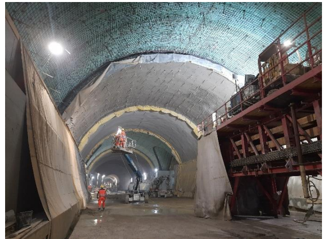
Abb. 8 Arbeitsschritte bei der Herstellung der SpC-Innenschale.
