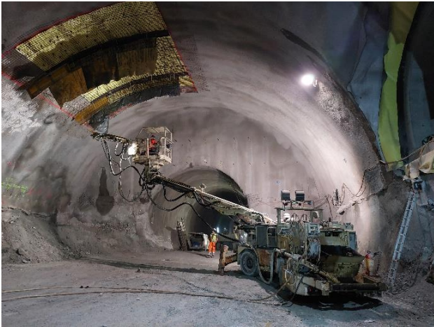
Abb. 4 SpC-Manipulator mit integriertem Bedienkorb bei Spritzarbeiten des Großversuchs.
