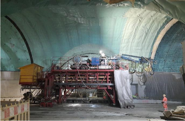
Abb. 5 Plattformwagen mit aufgebautem Spritzbetonmanipulator.
