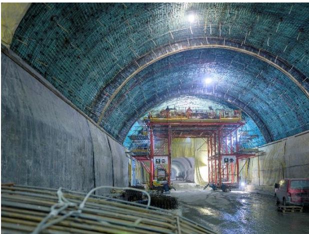
Abb. 7 Bewehrungswagen im Zuge der Vorbereitungsarbeiten. ÖBB/Ebner
