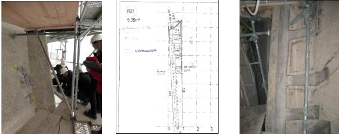
Bild 5: Schadstellen- und Rissbearbeitung mit Enthaftungsstreifen
