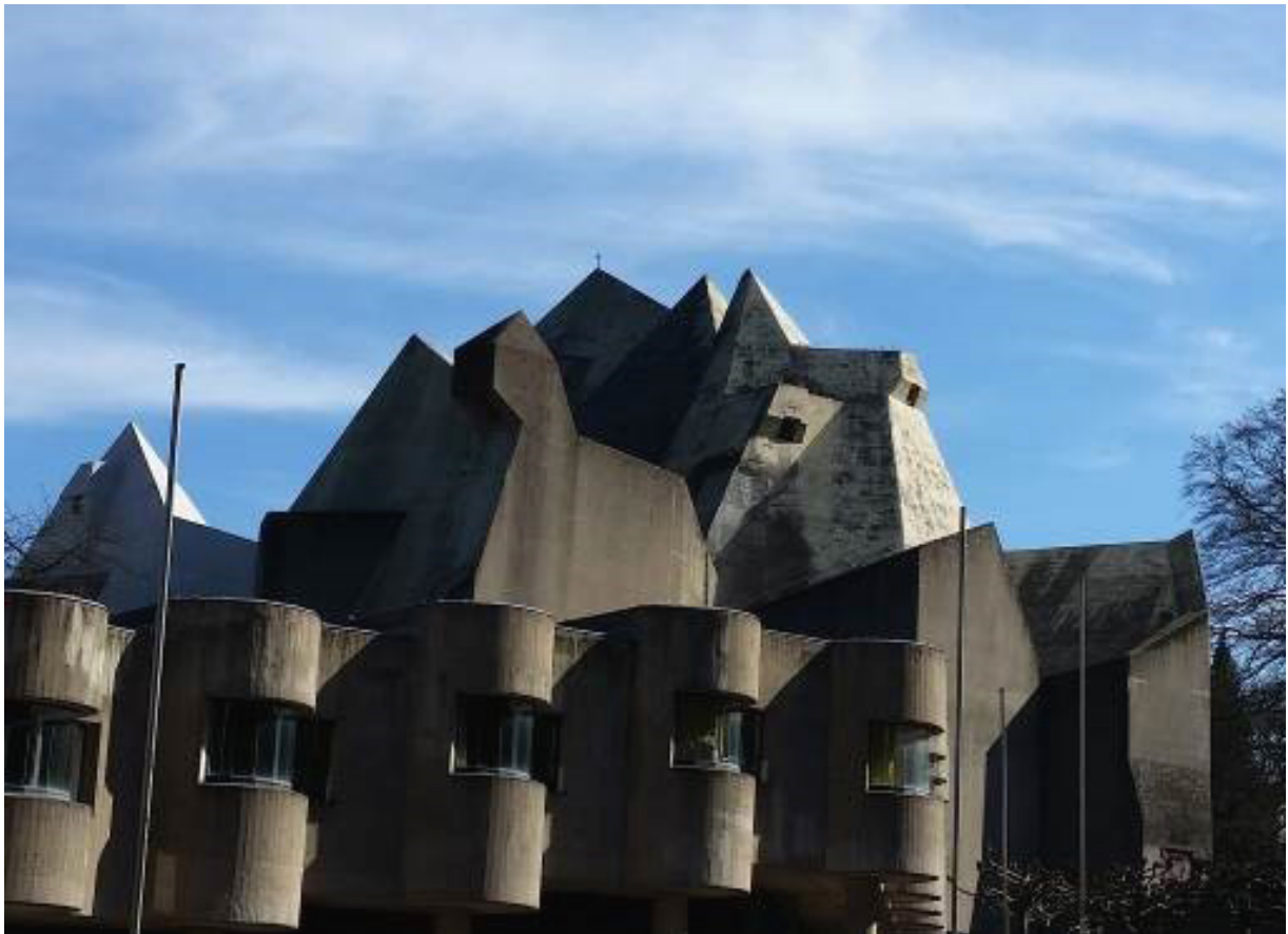
Bild 8: Ansicht der instandgesetzten Sakramentskapelle (linker Bildrand)
