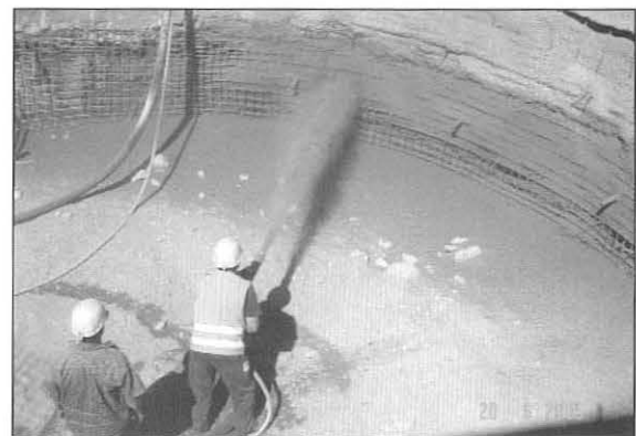
Bild 9: Spritzbeton im Schacht
