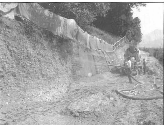
Bild 8: Nassspritzbeton zur Böschungssicherung
