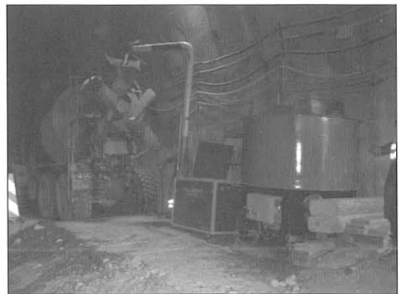
Bild 5: Zugabe von Stahlfasern
