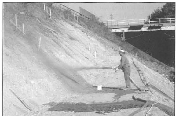
Bild 10: Böschungssicherung mit Spritzbeton
