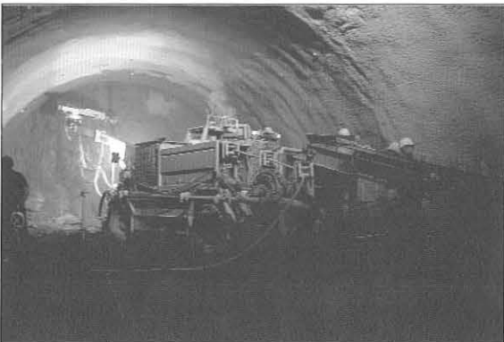
Bild 7: Spritzbetonverarbeitung unter Druckluft
