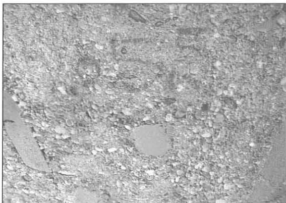
Bild 4: Untersicht Decke, Rautiefemessung
