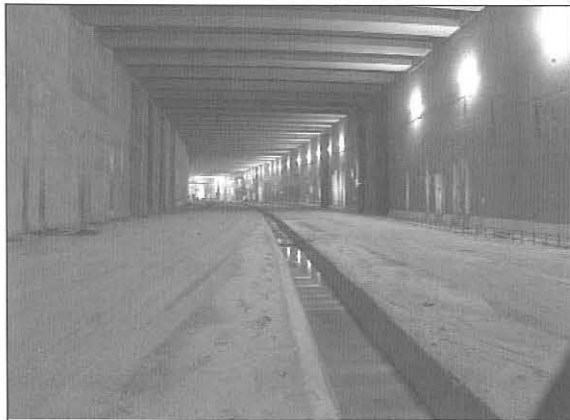
Bild 1: Lainzer Tunnel LT 23
