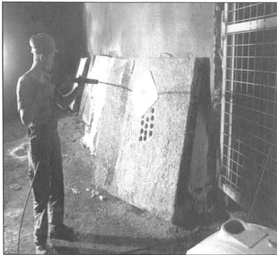
Bild 21: Ermittlung der Abtragtiefe mit einem Druckwasserstrahl
