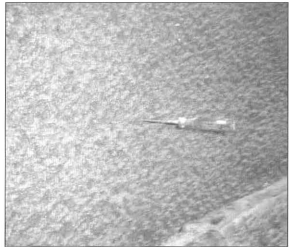
Bild 26: Brandbeständiger Spritzbeton
