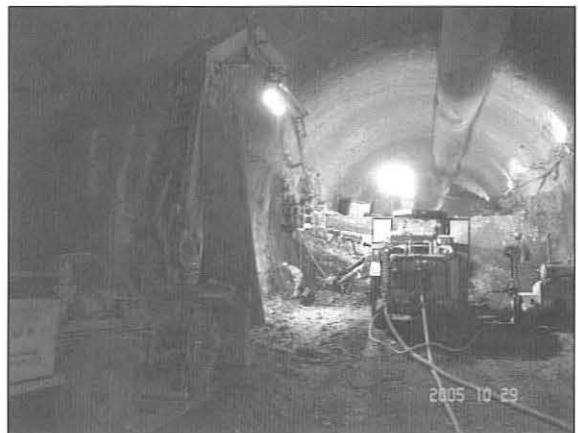
Bild 6: Überpumpen Inselvortrieb
