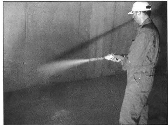
Bild 8: Naßspritzverfahren mit Förderung im Dünnstrom: Spritzvorgang
