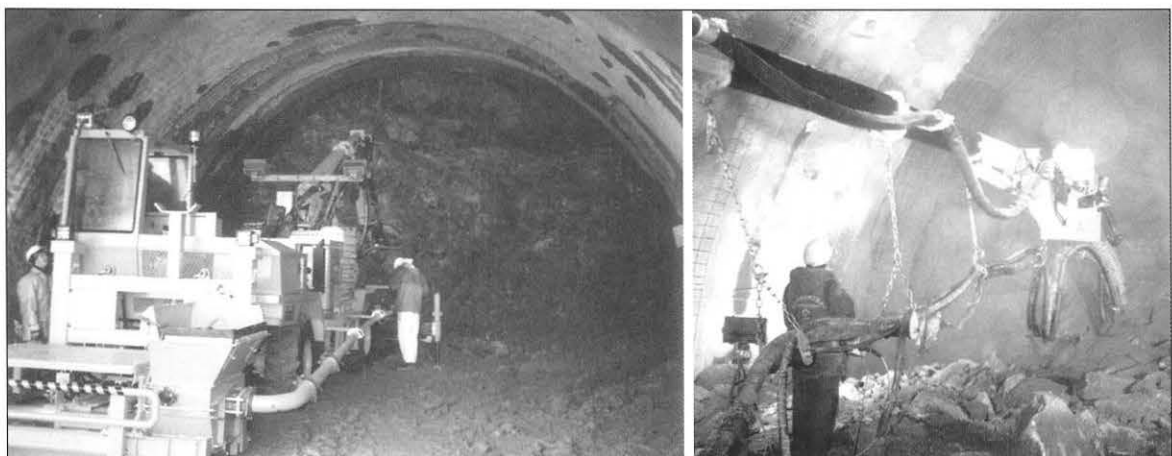
Bild 14: Spritzbetonmanipulator im Einsatz
