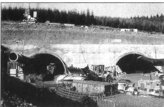
Bild 5: Voreinschnitt Ost mit Spritzbetonwand
