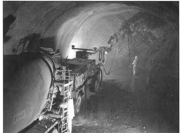
Bild 2: Betonspritzsystem mit Teleskopspritzarm
