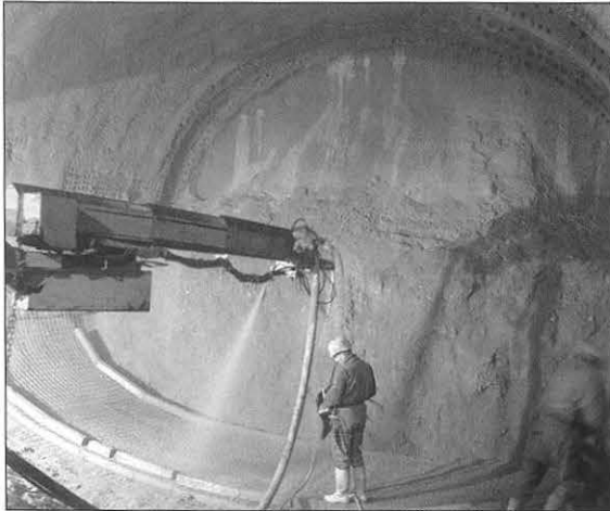
Bild 6: Arbeitsvorgang - Nassspritzen im Dünnstromverfahren
