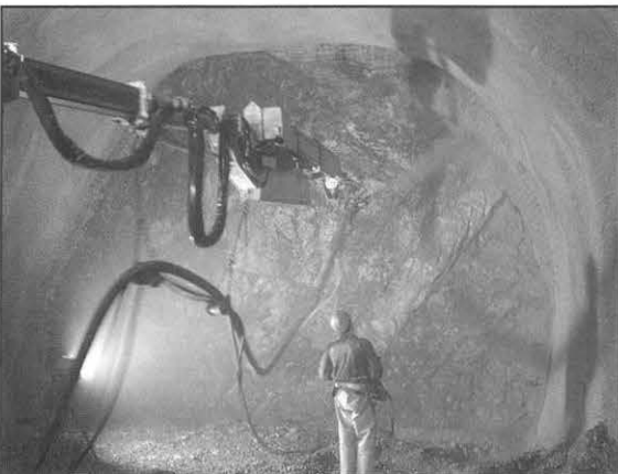
Bild 4: Düsenführer beim Einsatz mit dem Teleskopspritzarm
