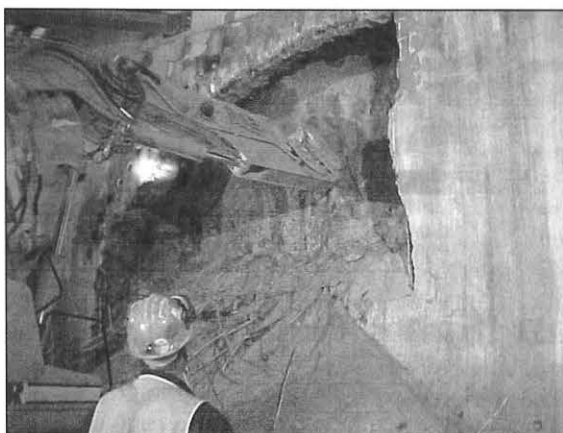
Bild 9: Princes Highway - Anschlag der linken Ulme
