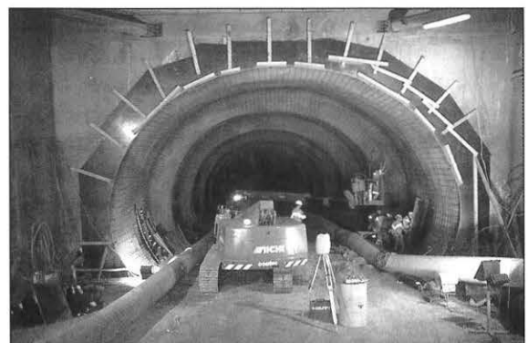
Bild 10: Princes Highway - Spritzbetoninnenschale
