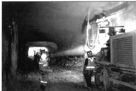
Bild 12: Spritzbetonauftrag
