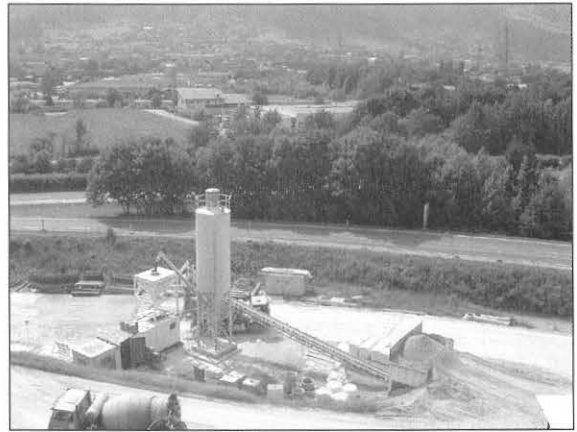
Bild 6: EKS Fiecht, Mischanlage am Portal
