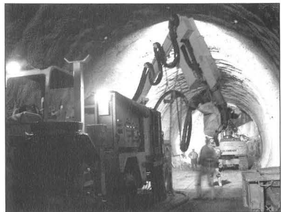
Bild 7: EKS Fiecht, gestaffelte Geräteaufstellung im Lockergesteinsvortrieb
