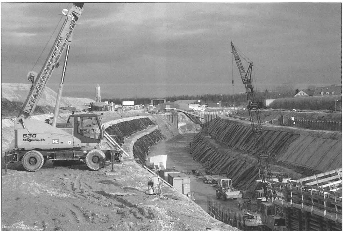
Bild 1: Vorauslaufende und begleitende Bauhilfsmaßnahmen zum Fernhalten des Grundwasser aus dem Arbeitsbereich (U-Bahn-Baulos U6 Garching bei München)
