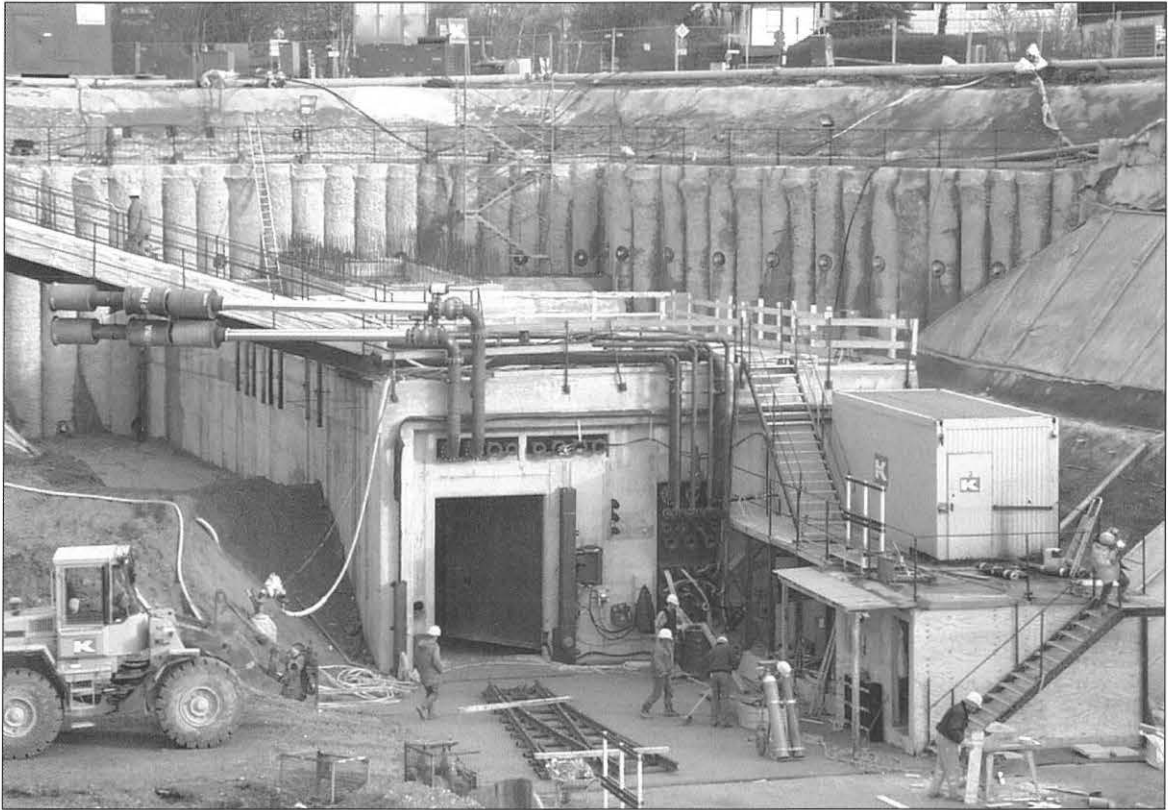
Bild 2: Tunnelportal mit Druckschleusenkammern (U-Bahn-Bau U6 Garching bei München)
