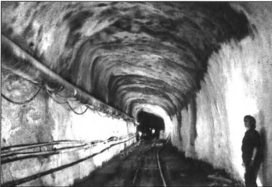
Bild 2: Einschaliger Ausbau mit Spritzbeton im Zuleitungsstollen Caveragno - Palagnedra der Maggia-Kraftwerke (Foto 18.3.1953, Ofima, Locarno)*
