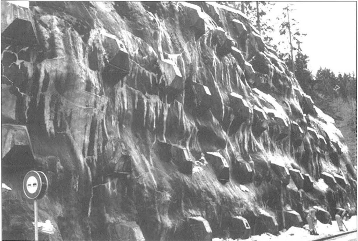
Bild 1: Hangsicherung an einer Bergstrasse
