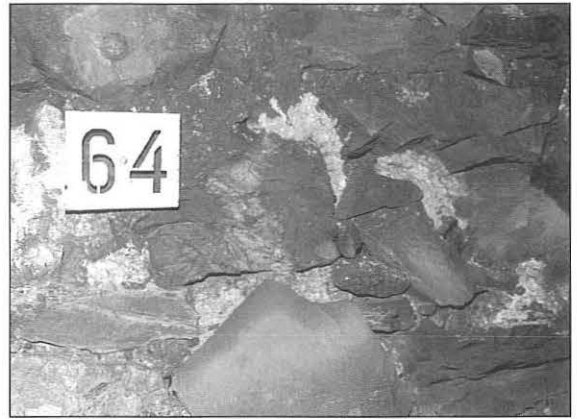
Bild 2: Mörtelschäden
