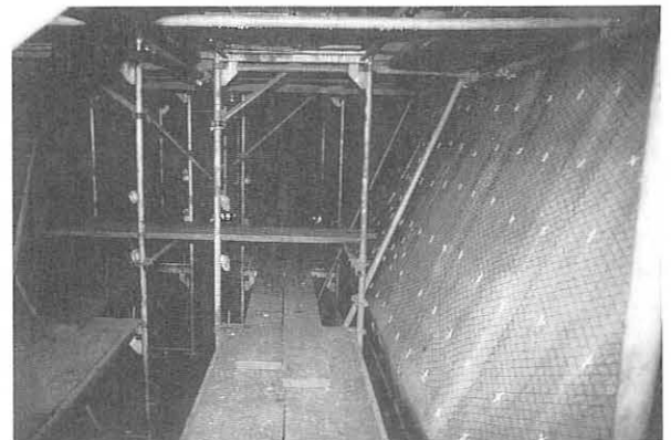
Bild 4: Kohlenbunkerwand mit den aufgedübelten Anodengittern vor dem Spritzbetonauftrag
