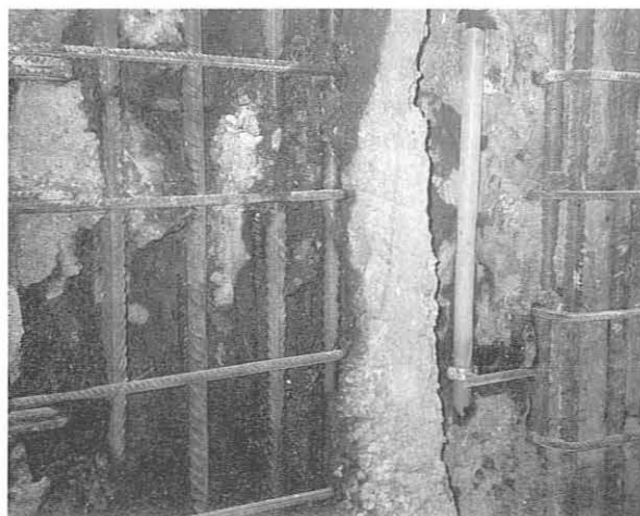
Bild 4: Freiliegende Schlitzwandbewehrung
