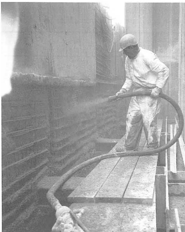
Bild 14: Aufbringen des Spritzbetons außen
