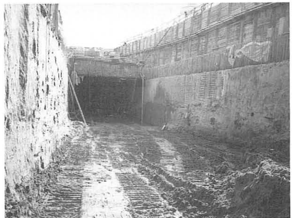
Bild 11: Freigelegte Schlitzwände innen
