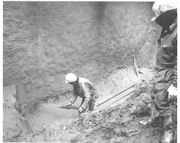
Bild 16: Aufbringen des Spritzbetons innen
