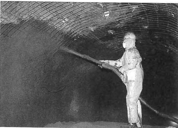
Bild 6: (Ecça Stollen) Trockenspritzen
