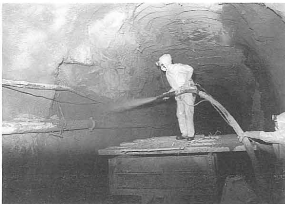
Bild 10: (Ecca Stollen) Stahlfaserspritzbeton
