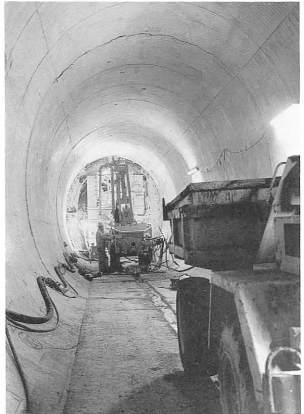
Bild 10: Innenschale eines zweigleisigen Tunnels
