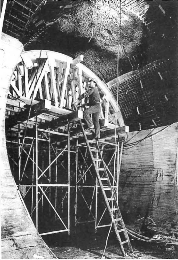
Bild 11: Handschalung bei einem Querschlag
