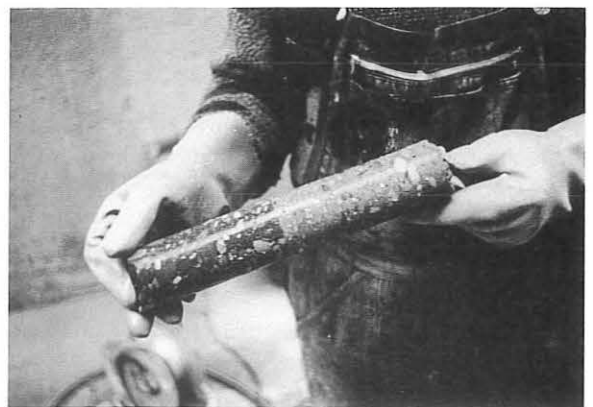
Bild 16: Bohrkern aus der Schleusenwand
