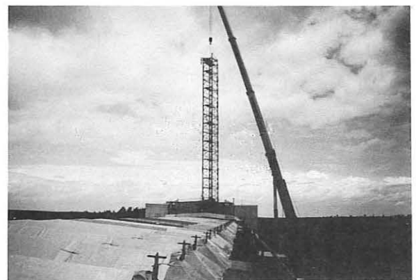
Bild 19: Umheben der Geräte
