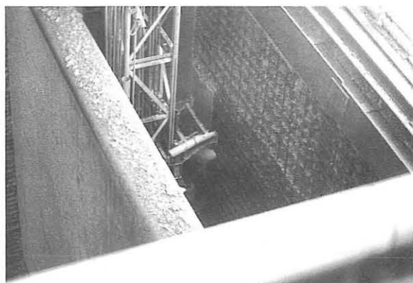
Bild 6: Kleiner Geräteträger beim Abbruch hinter der Torprallwand
