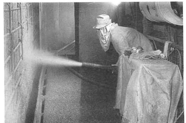
Bild 14: Applizierung des Spritzbetons
