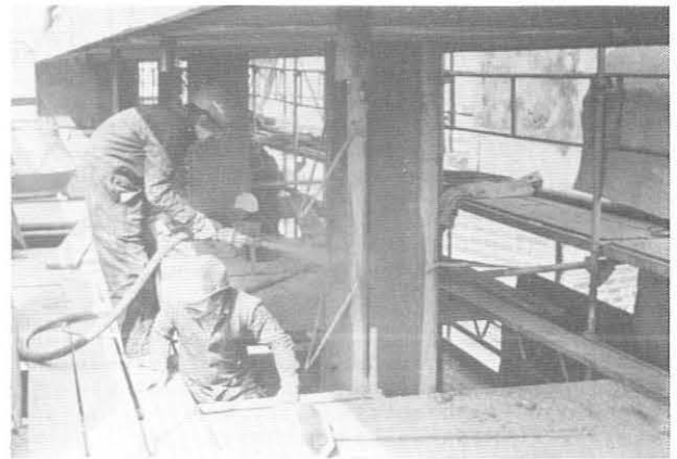
Abb.2. Sanierung von Fassadenstützen mit Spritzbeton.
