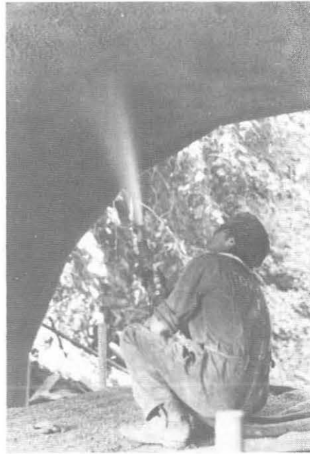
Abb.5. Sanierung einer Gewölbebrücke.
