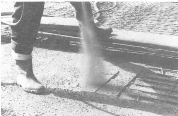
Abb.4. Verstärkung einer Fahrbahnplatte mit Spritzbeton.
