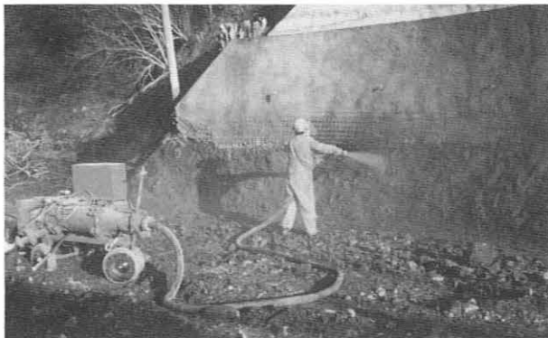
Abb.6. Hangsicherung als Dauermaßnahme mit Kunststofffaserspritzbeton.
