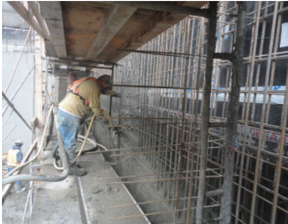
Bild 3a/3b: „Bench Gunning“ (Bild: Metro Testing Laboratories Ltd.)
