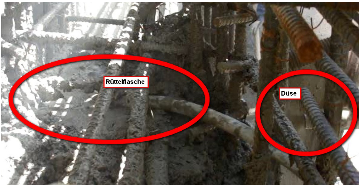
Bild 4: Nachverdichten mittels Innenrüttler (Bild: Metro Testing Laboratories Ltd.)
