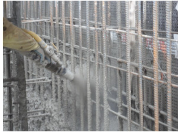
Bild 3a/3b: „Bench Gunning“ (Bild: Metro Testing Laboratories Ltd.)
